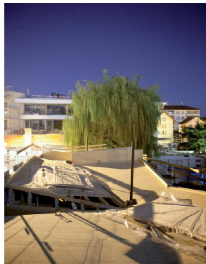
Vue nocturne du chantier de la place du Marché (Photo Matthieu Gafsou)
