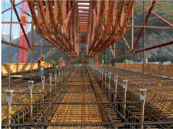
toute la nuit pour couler quelque 330 m<sup>3</sup> de béton. Plusieurs mesures de contrôles qualité ont été effectuées, parmi lesquelles celle du contrôle de l'évolution de la flèche du cintre lors de la mise en place du béton: la flèche mesurée de 48 mm était très proche des 50 mm déterminés par le calcul, prouvant l'excellent travail de tous les intervenants.
