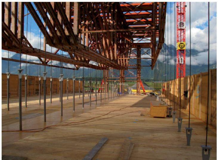
Fig. 8 : Coffrage et ferrailage du tablier sur le platelage
