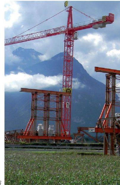
Après la prise du béton et la mise en précontrainte de la travée, le tablier devait être suspendu avec des câbles à deux portiques placés au droit des piles, pour être ensuite abaissé dans sa position définitive (fig. 4). Les piles devaient être bétonnées sur des socles avant l'abaissement du tablier et être fixées à ce dernier; la liaison après abaissement aurait été faite directement dans la semelle de fondation.
