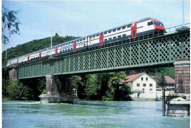
tée depuis 1999 par des trains de voyageurs CFF répondant aux exigences de la classe de ligne B1 (selon directive des chemins de fer européens : charge admissible par essieu de 180 kN, charge maximale linéaire de 50 kN/m).
