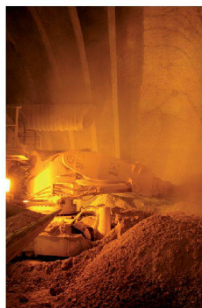
Dans le tunnel de Serrières, pendant les travaux d'excavation (Photo PC)
