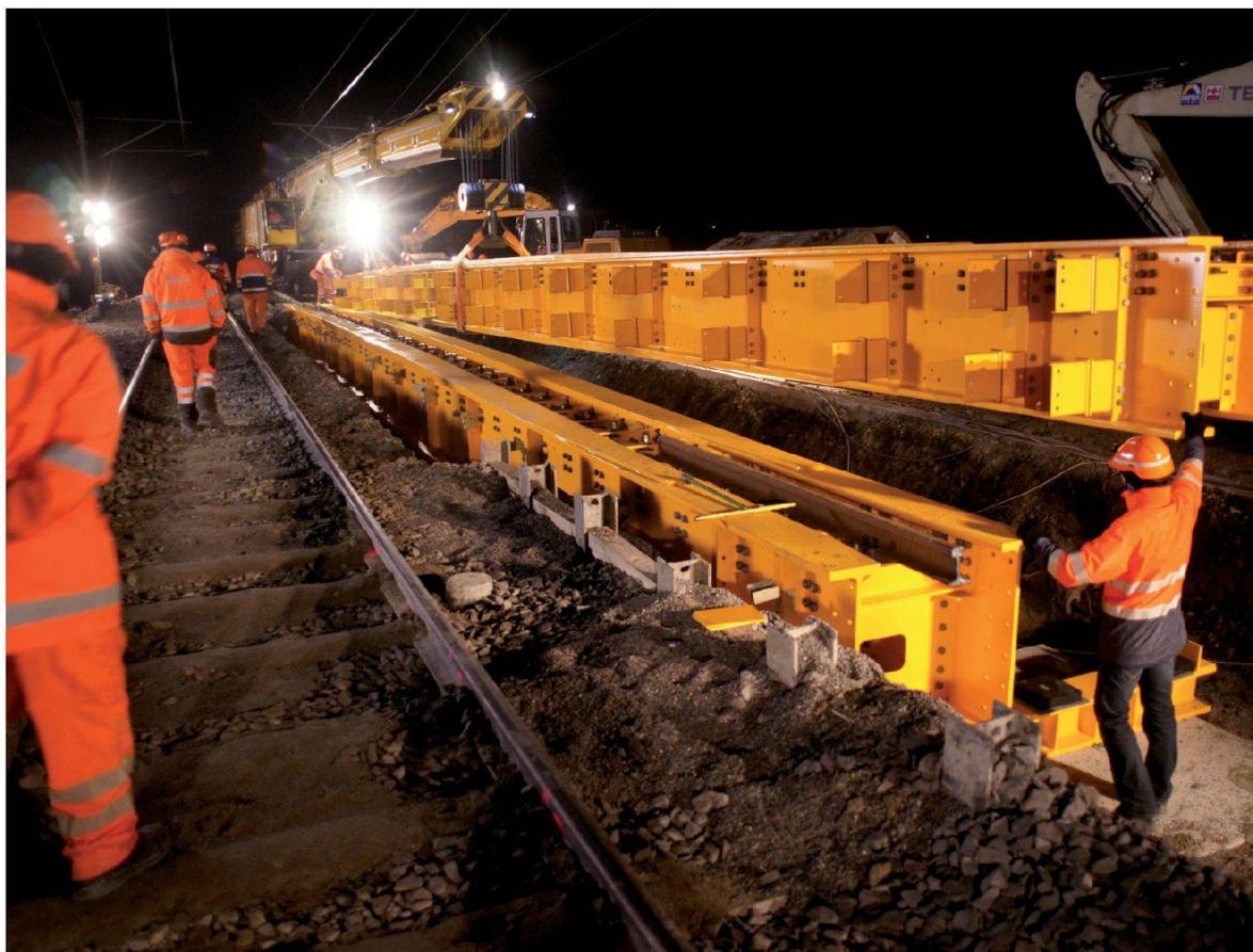
Fig. 8 : Bétonnage du PI avec les premiers ponts provisoires PPI (Photo Etat de Fribourg / Eric Sauterel)
