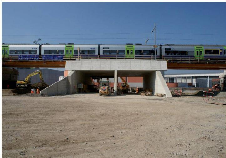
Fig. 1 : Le passage inférieur avec les seconds ponts provisoires PP2 (Photo Etat de Fribourg / Eric Sauterel)
