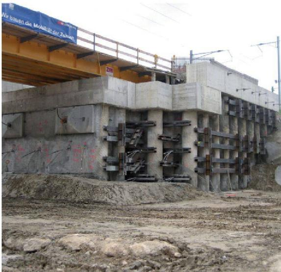
se compose de quatre niveaux d'ancrages sur la hauteur totale de la fouille, respectivement trois niveaux sous le PI, où le radier de ce dernier sert de buton.
