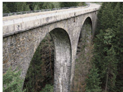
Le pont sur la Dala à Rumelng (Photo Alix Grandjean)
