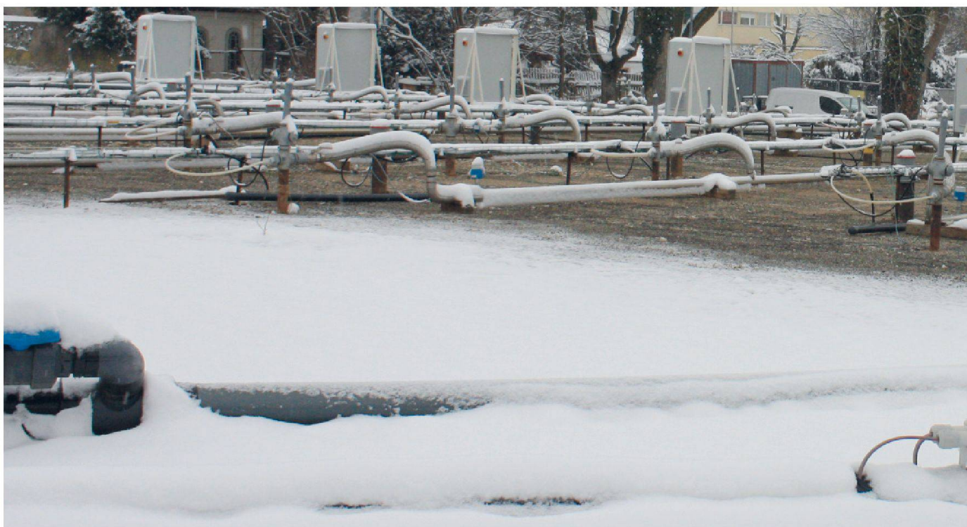
1 Chauffage du sol pour l'extraction des polluants (Photo Veolia)
