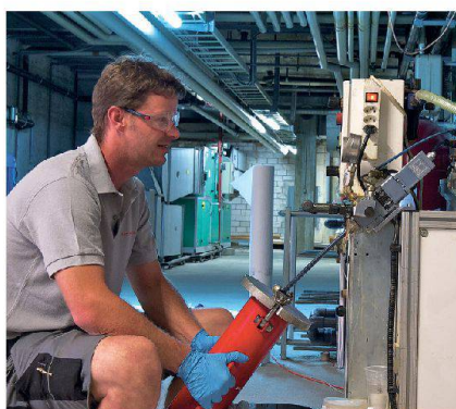
Une fois mélangée et dosée, la résine est conditionnée dans des cartouches en vue de son injection à l'intérieur du circuit réalisée sur place.
