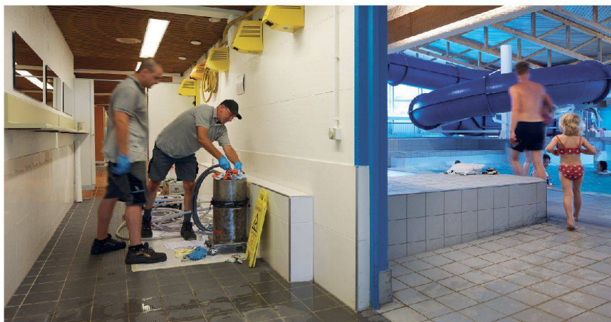
Assainissement par l'intérieur avec le Système HAT: pas de chantier. Pas de démontage. Pas de décombes. Pas de bruit. Et pas d'interruption de l'activité.
