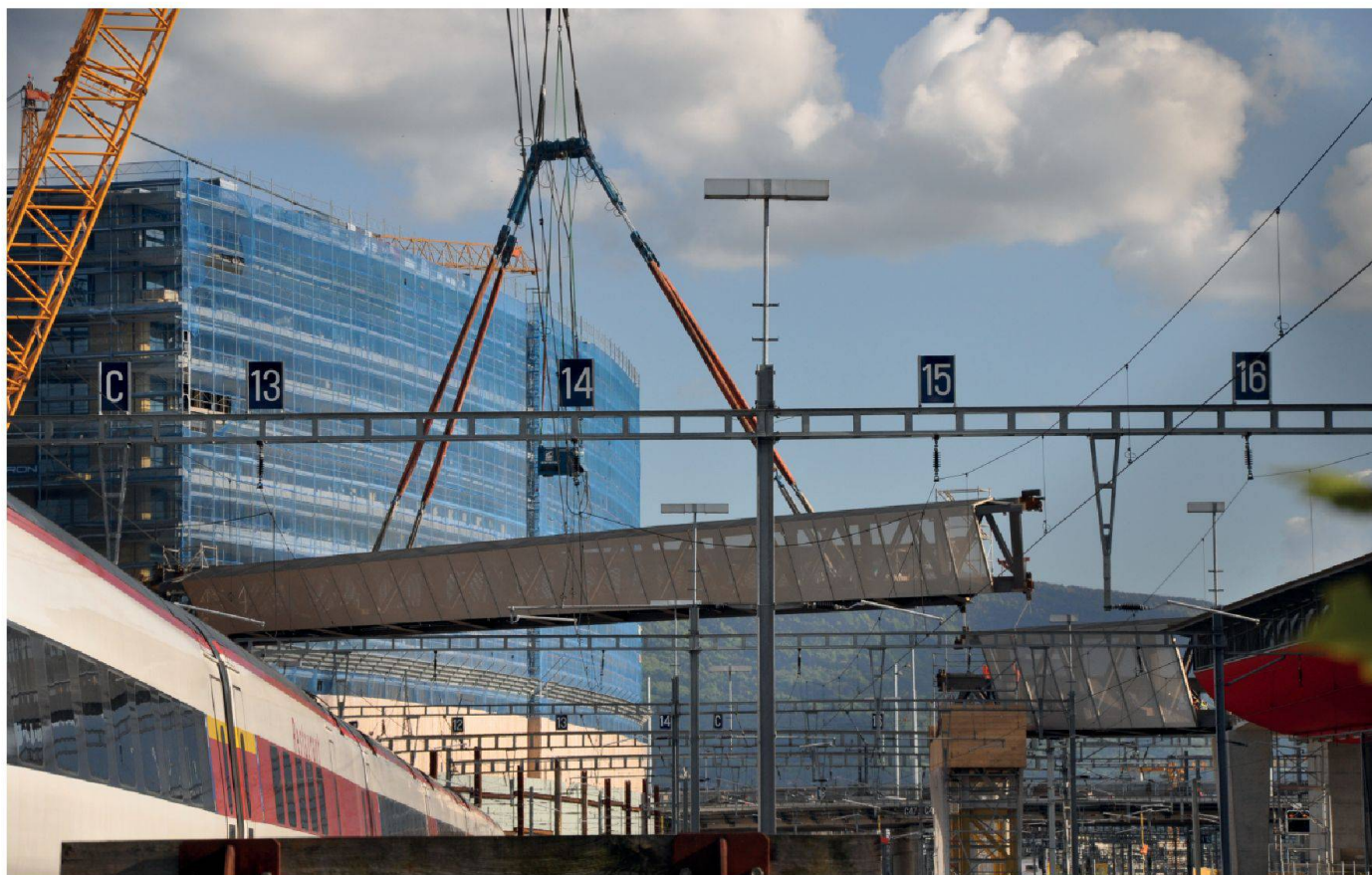
16 Pose du tronçon 6, avec le dispositif pour le réglage de la longueur des élingues (Photo ZM)
