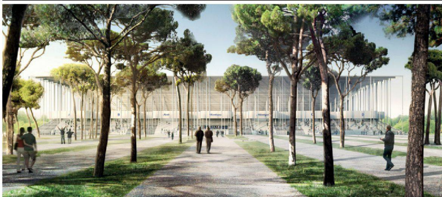
Le nouveau stade de Bordeaux de Herzog & de Meuron (Image Herzog & de Meuron)
