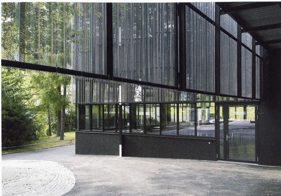
11, 12 La tôle perforée qui habille l'ensemble est noire de l'extérieur et métallisée de l'intérieur.
