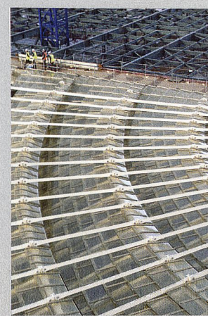
Vue du chantier de la Canopée (© Franck Badaire)
