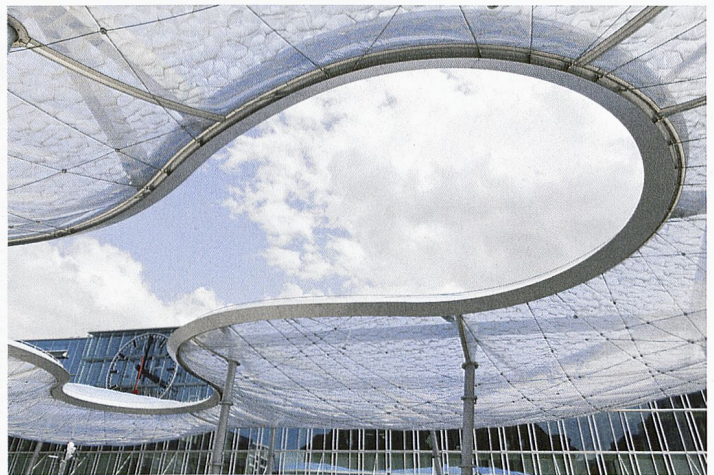
L'abribus de la nouvelle place de la gare d'Aarau (Photo Eduard Hueber)
