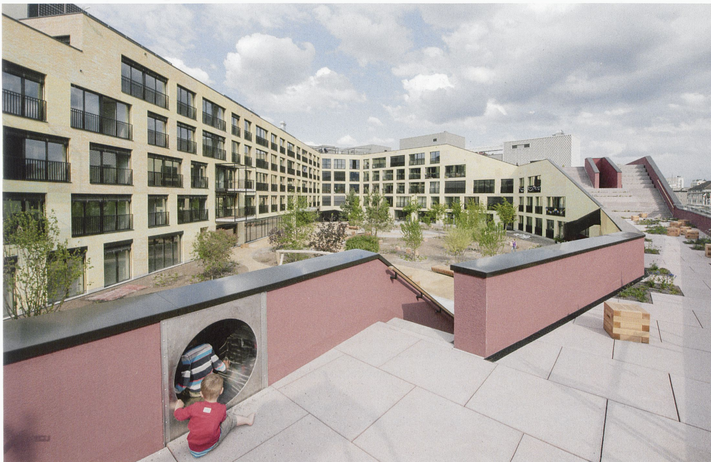
1 Vue du projet Kalkbreite, réalisé en 2014 à Zurich (Photo Ruedi Weidmann)
