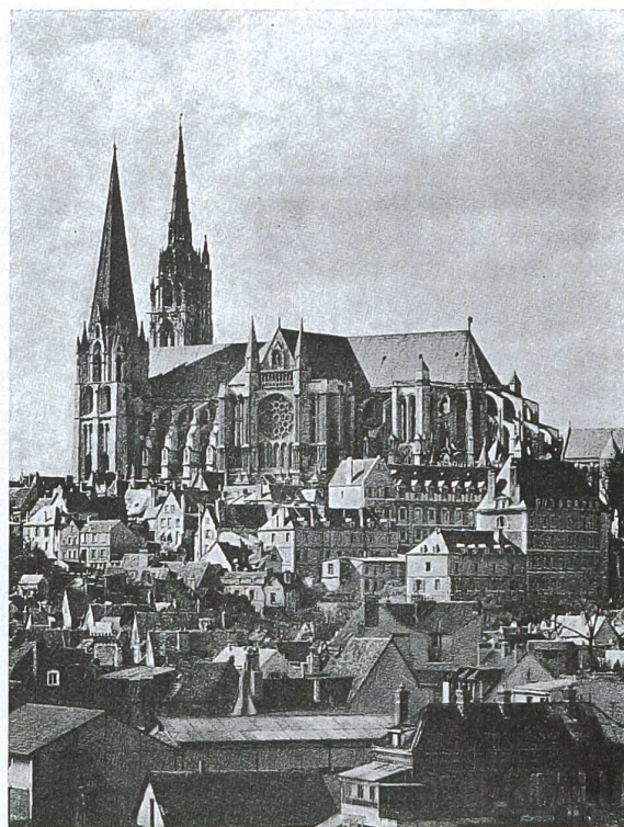
Fig. 16. — Cathédrale de Chartres, 1194-1220. Vue générale. Remarquer les tours de blocage indiquées à la figure 15 et les arcs-boutants.
