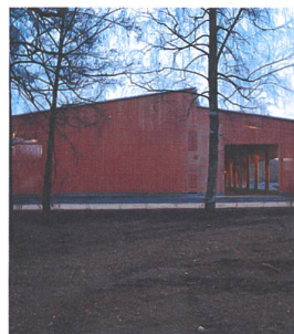
Complexe communal, centre de voirie et déchetterie Kommunaler Werkhofkomplex Saint-Prex (VD), 2009-2011
