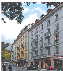
Ilot Riponne-Tunnel, rénovation de sept immeu- bles de logements sociaux Häuserblock Riponne-Tunnel, Renovierung von sieben Wohnbauten mit Sozialwohnungen Lausanne (VD), 2004-2006 → Page/Seite 18/22
