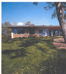
Villa individuelle Einfamilienhaus Préverenges (VD), 1996-1997, réalisée avec Pier Lovat
