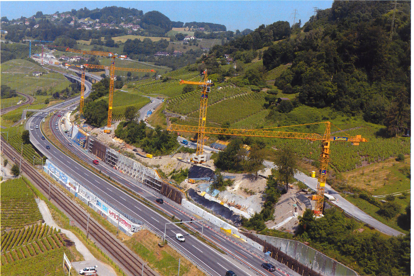
6 Renforcement de murs sur l'A9 (photo Groupe Zuttion) (Sauf mention, tous les documents illustrant cet article ont été fournis par les auteurs.)
