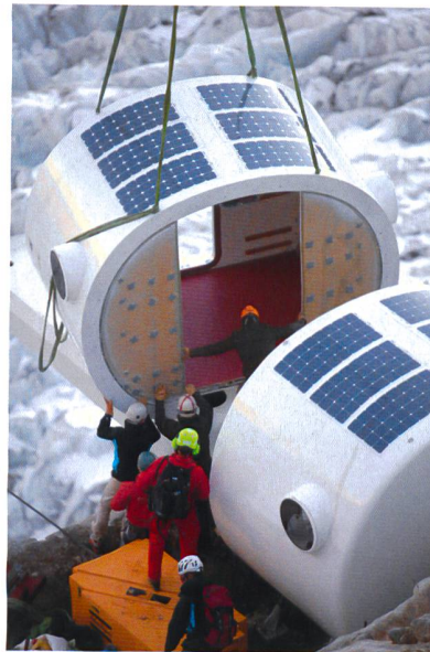
Mise en place par hélicoptère d'un module du refuge Gervasutti, au-dessus de Courmayeur (Italie) (photo Francesco Mattuzzi)
