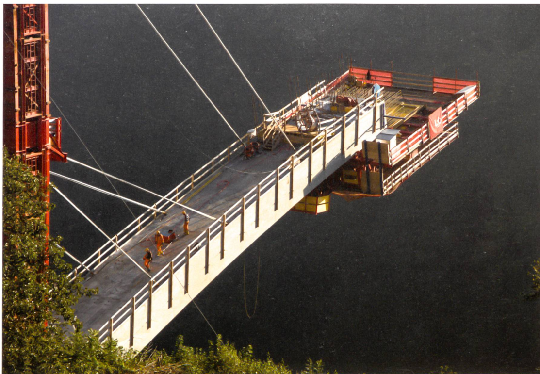
5 Réalisation de l'arc en encorbellement. (Sauf mention, tous les documents illustrant cet article ont été fournis par Leonhardt, Andrä und Partner et les photos sont de Werner Fetzler)
