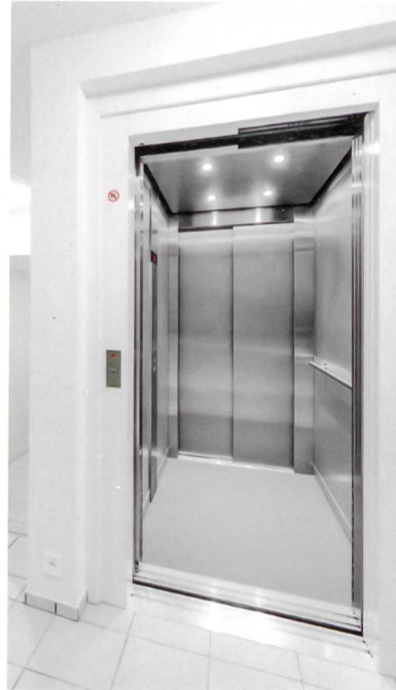
AS a monté 22 ascenseurs de type Magic sans local de machines.
