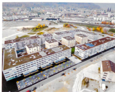
Le Grand ensemble est composé de plus de 400 nouveaux appartements.
