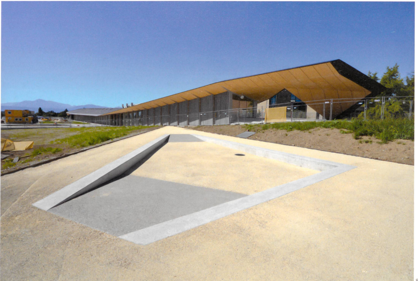
8 Vue d'ensemble du pavillon depuis la toiture nord (Sauf mention, tous les documents illustrant cet article ont été fournis par INGPHI SA.)
