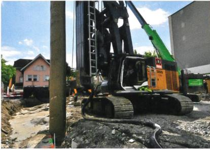
JMS RISI AG a dû réaliser une excavation dans une enceinte étanche à Zoug, car l'excavation était située dans la nappe phréatique pour deux niveaux souterrains. A cause de l'espace disponible, des émissions sonores et des vibrations, il n'a pas été possible d'opter pour des parois moulées ni des palplanches. JMS RISI AG a donc mis sur une paroi de pieux sécants (770 mm de diamètre), qui a été réalisée avec l'engin de forage Liebherr LRB 355 selon la méthode du forage à double tête.
