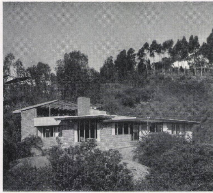
Ansicht von Süden. Vue du sud. View from the south.
