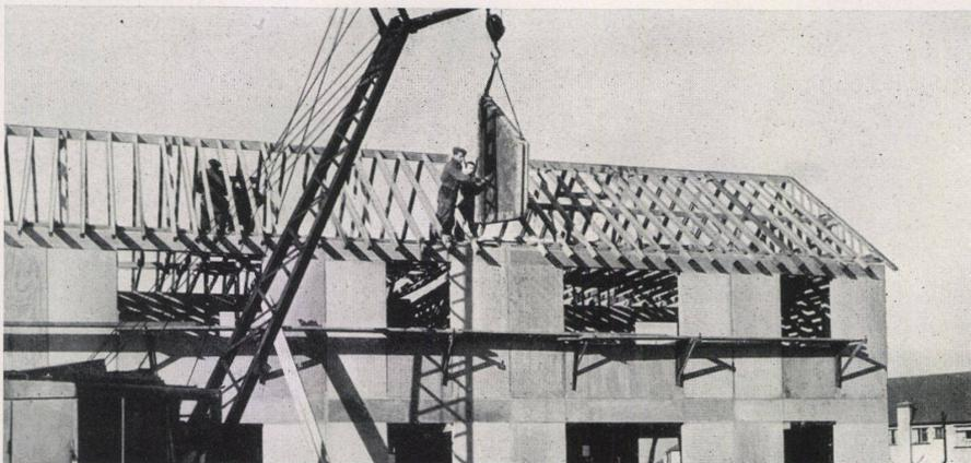
Dachstuhl / Charpente du toit / Framework of roof
