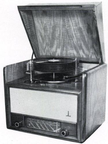
Tischmodell Paillard Nr. 3502/G in Nußbaum, mit Grammokombination, 5 Lampen, Telephonrundspruch, Tonregulierung. Dimensionen des Gehäuses: 510 x 418 x 369 mm.
