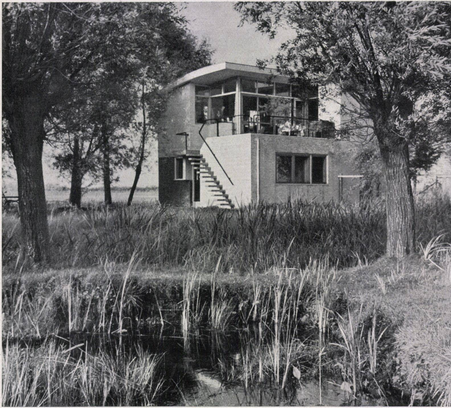
Gesamtansicht Vue générale General view
