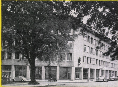
Schweiz: Büro- und Geschäftshaus, Zürich
