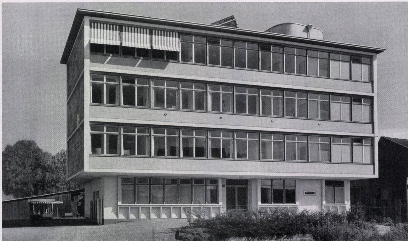
Das Bürogebäude mit Eingang von Westen. Le bâtiment des bureaux avec l'entrée à l'ouest. Office building with entrance, seen from the west.
