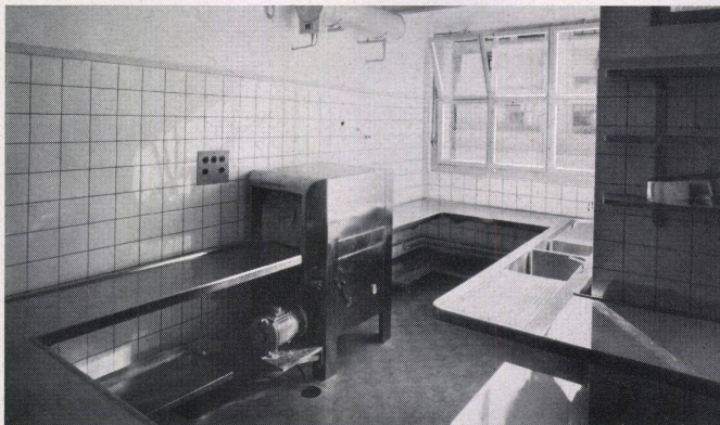
Spülküche mit Geschirrspülmaschine und Chromstahltrögen.
