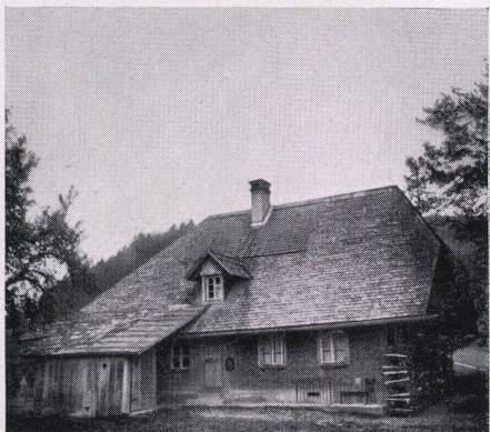
Links Toiletten, rechts Klassenzimmer
