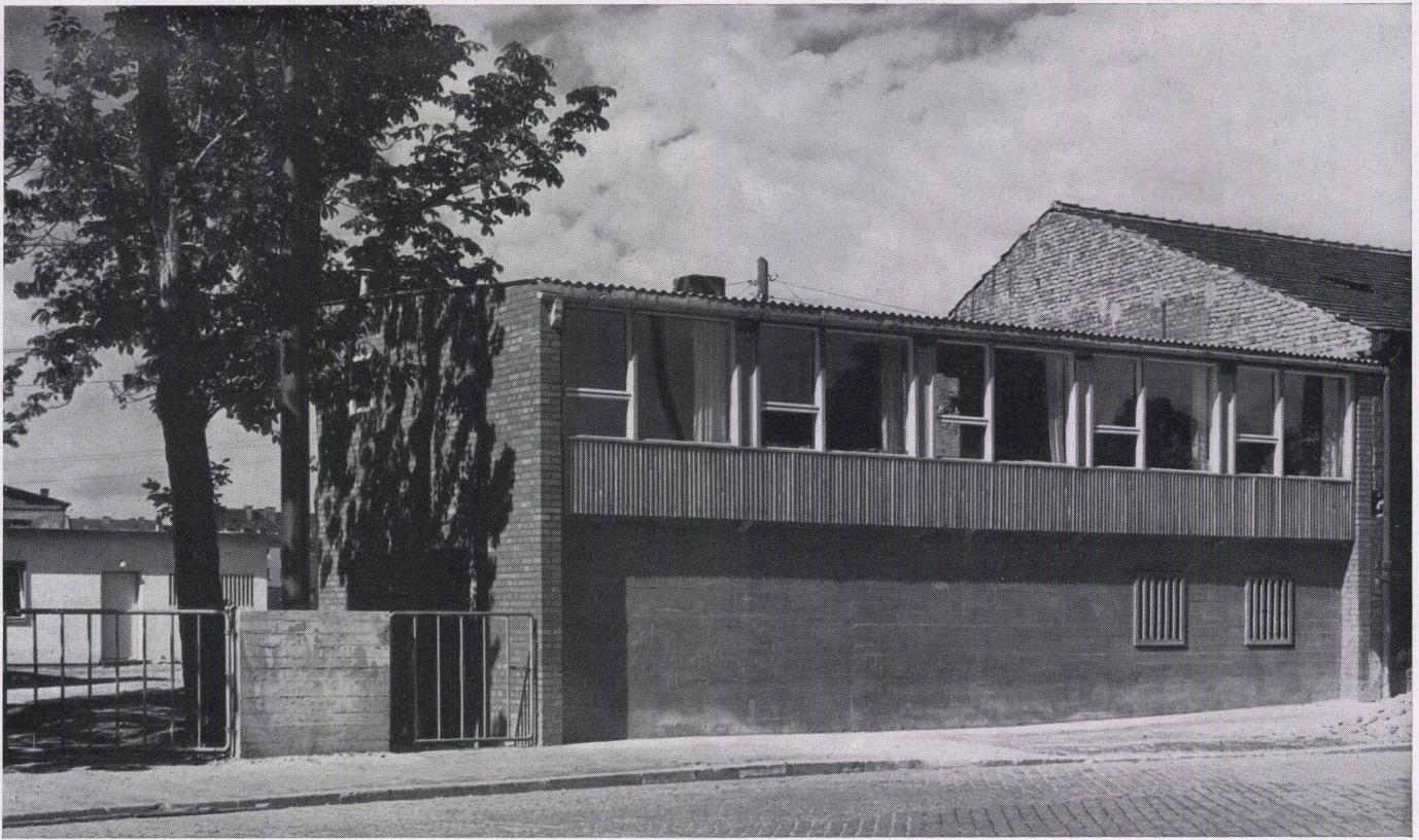
Ansicht von der Straße (Norden). Im Obergeschoß der Zeichensaal / Vue prise de la rue (côté nord). A l'étage supérieur la salle de dessin / View from the street (North). In the upper storey drawing office.
