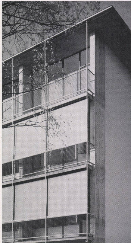
Südfassade mit teilweise hochgeklappten Schwingflügeln. Façade sud. South façade.
