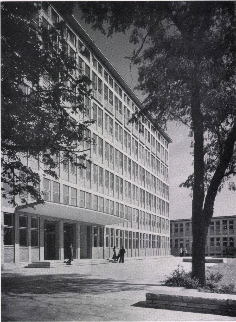
Haupteingang des siebengeschossigen Verwaltungsbaues. Hinten der zweigeschossige Flügel der männlichen Berufs- vermittlung. Entrée principale du bâtiment administratif à sept étages. Main entrance of the seven-storey administrative building.
