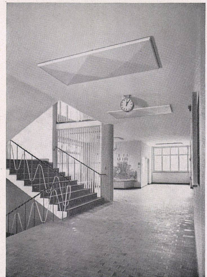
Abb. 3 Treppenhaus mit Decken- Strahlungsheizung
