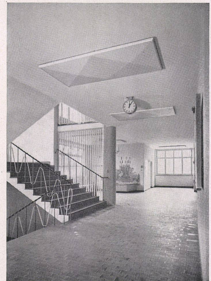
Abb. 3 Treppenhaus mit Decken- Strahlungsheizung
