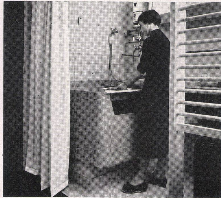
Blick in Kleinküche. Der Trog wird als Spülbecken verwendet. Neben dem Trog der Durchlauferhitzer. Vue de la cuisine. L'auge sert d'évier. Le boiler est à côté de l'auge. View into the kitchenette. The trough is used as a washing-up bowl. Near the trough, the flow heater.
