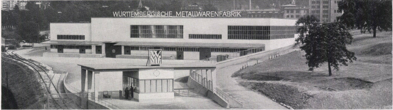
Pförtnerhaus mit Durchfahrt zu den Fabrikanlagen. Loge de concierge avec passage vers la fabrique. Porter's lodge with passage through to factory installa- tions.
