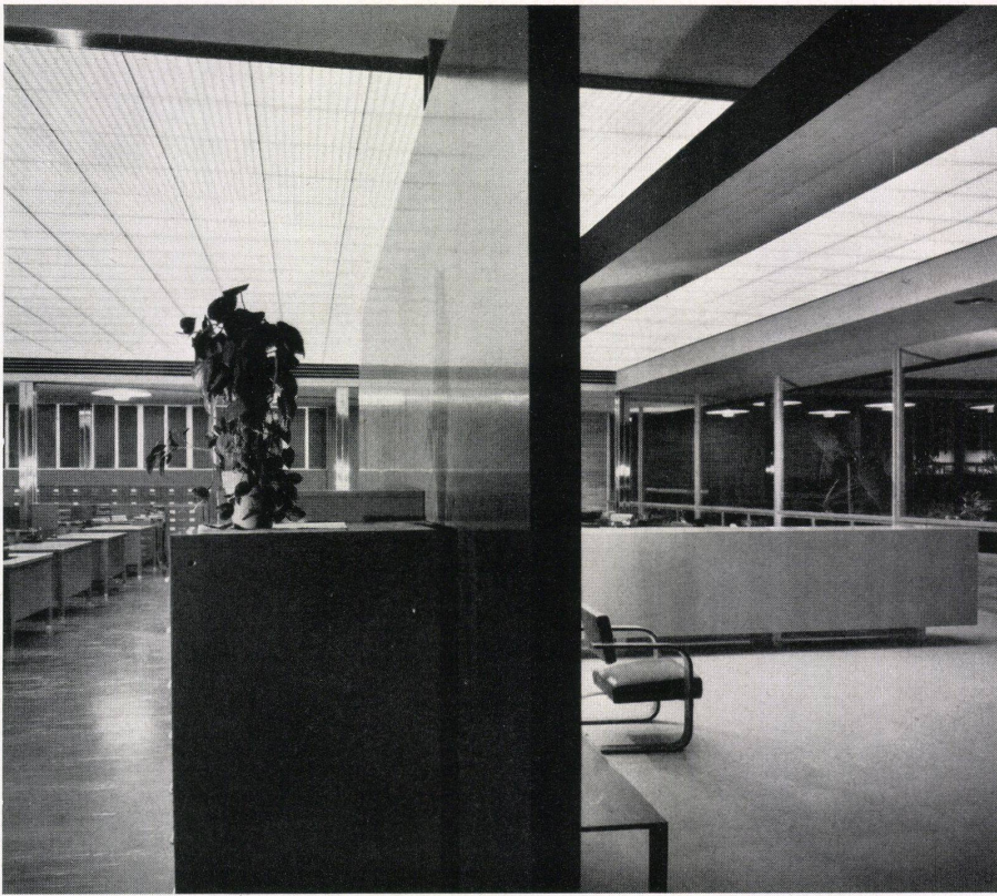
Blick in die Bürohalle mit den Pulten. Die ganze Decke ist als Beleuchtungsfläche ausgebildet: Lichtraster mit darüber angeordneten Fluoreszenzröhren. Rechts Blick in den Publikumsvorraum mit der Auskunft.
