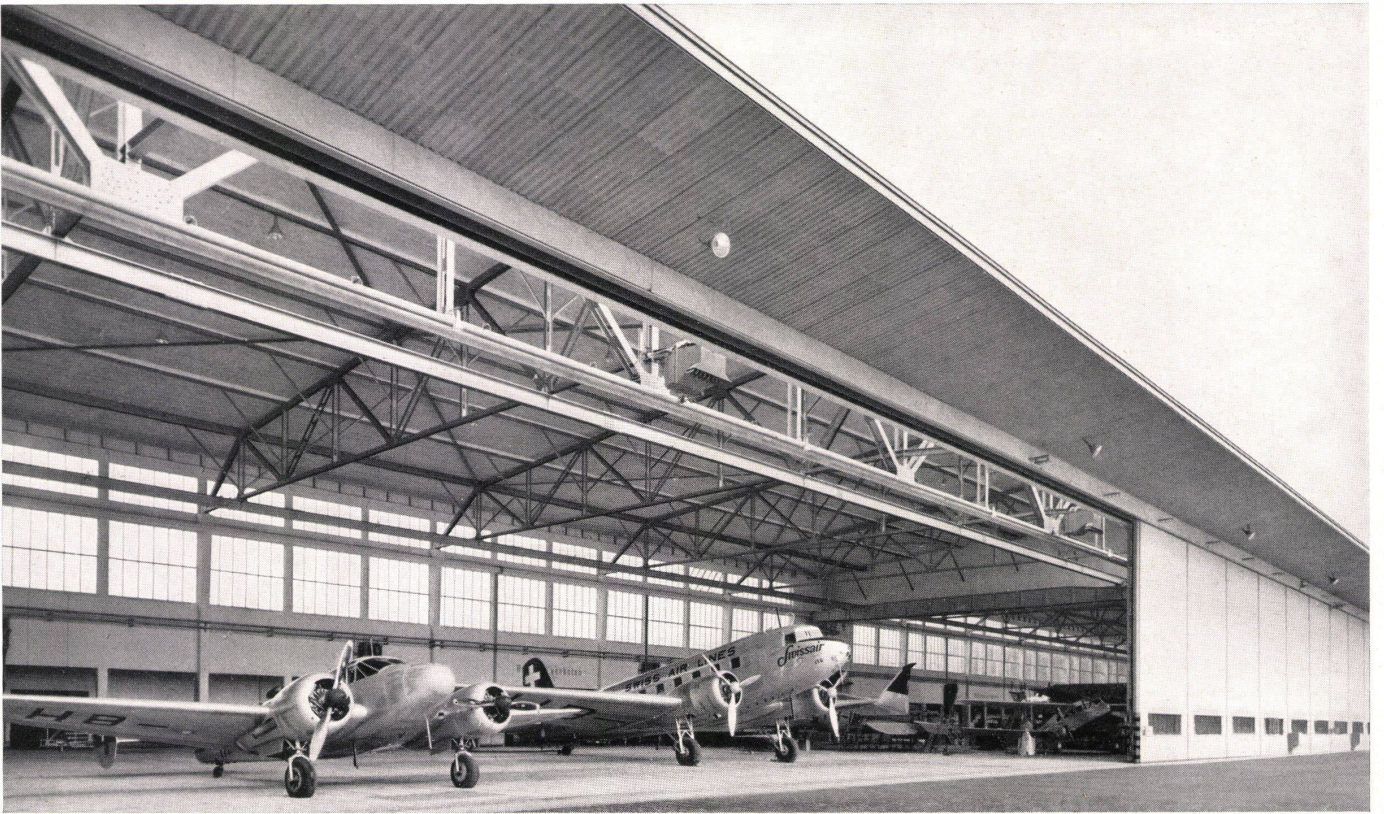
Kloten/Zürich Werfthalle. Salle de construction. Workshop.
