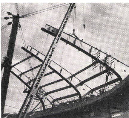
Montage der Stahlbinder. Montage des fermes en acier. Mounting of the steel trusses.
