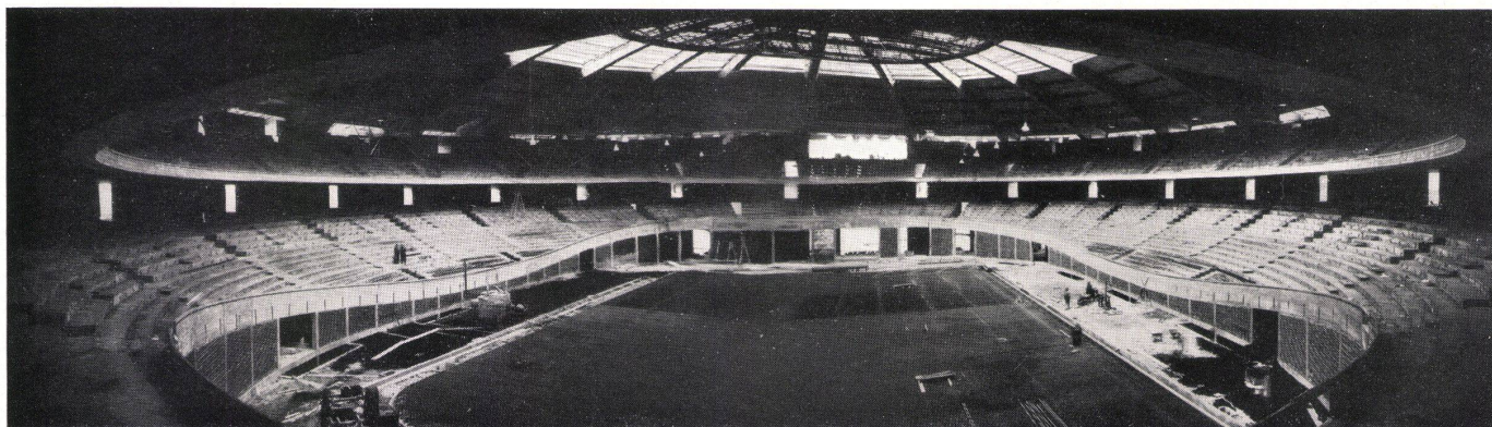
1 Stahlbetonkern mit den Sitzreihen im Rohbau. Les soubassements et la partie principale du hall en béton armé. Bare reinforced concrete construction with rows of seats.
