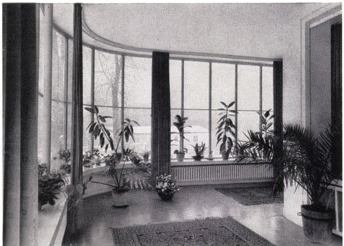
Diese gebogene Fensterwand eines Wintergartens ist mit Cudo-Doppelscheiben verglast, die auch bei hoher Außentemperatur blank bleiben.
