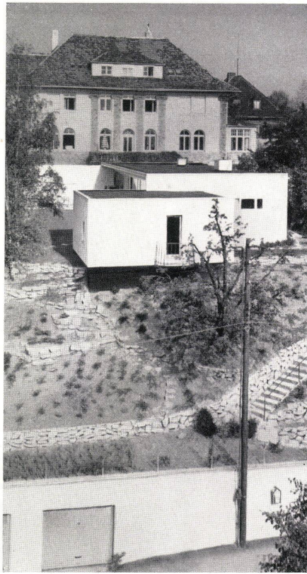
Ansicht von Süden mit Zugang und Garage. Vue du sud avec l'entrée et le garage. View from the south entrance and garage.
