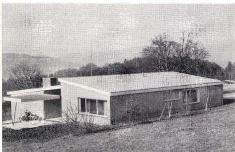
Projektiertung: Architekt W. Müller, Zürich — Ausführung der FURAL-Bedachung durch die Spezialfirma Spenglerei O. Kaufmann, Baden
