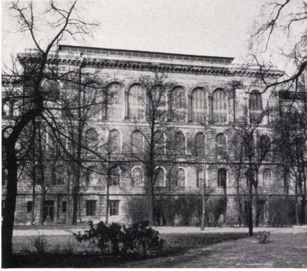
Technische Universität Berlin. Bibliotheksräume im 3. Obergeschoß.
