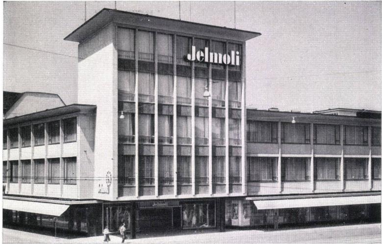
et d'une profondeur de 4,60 m (+ 0,40 m pour un placard à dossiers). Trois bureaux de 2,80 x 3,80 m, placés de travers, s'avancent vers le nord et vers le sud. La construction portante est une combinaison de squelettes en béton armé et en acier. Les supports intérieurs et les sous-poutres sont en béton armé; les supports extérieurs en acier agissent comme des appuis pendulaires.
