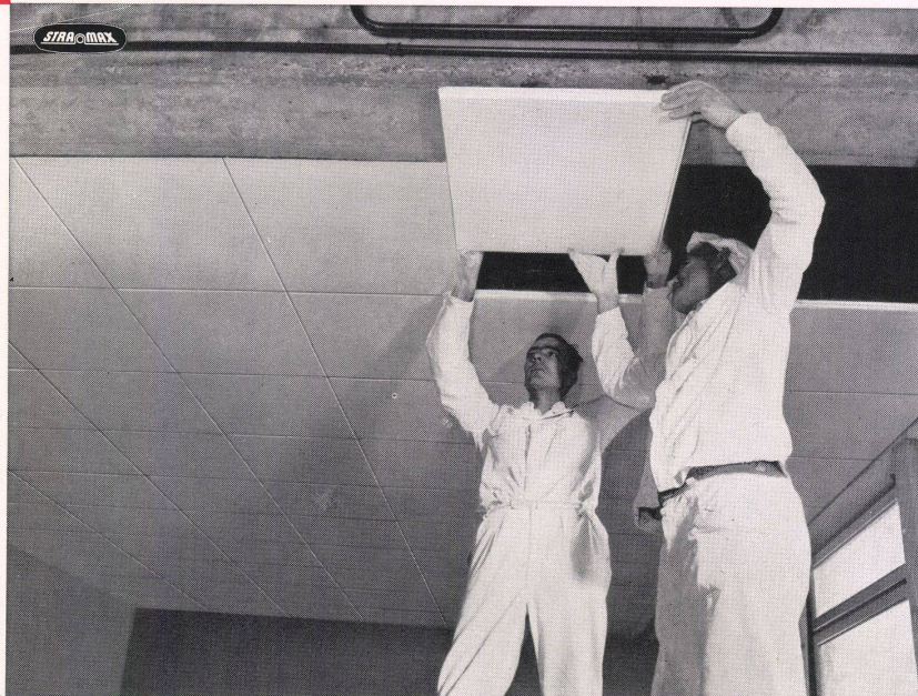
Schweiz. Impf- und Serum-Institut, Bern STRAMAX-Heiz- und Kühldecken in Montage
