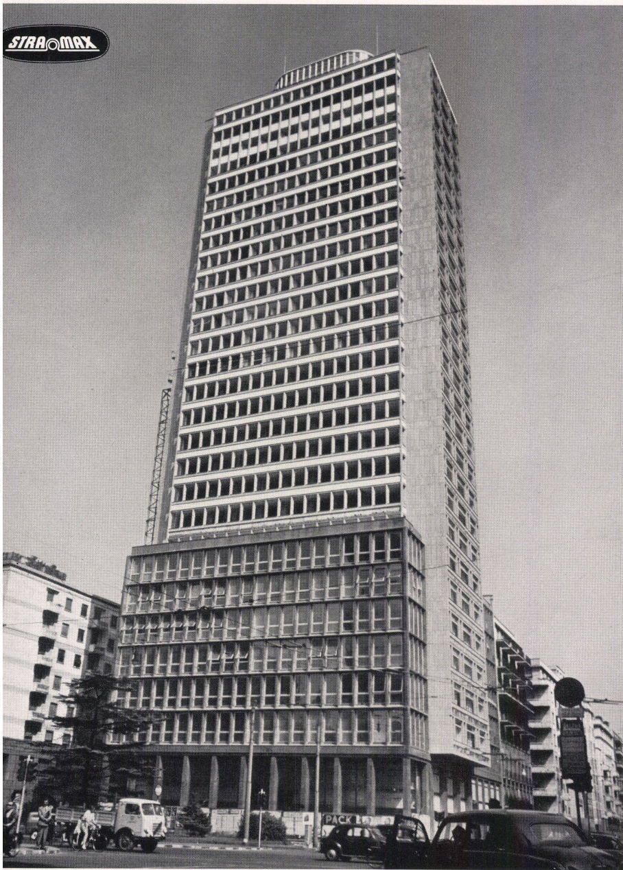
Hochhaus Grattacielo di Milano 31 Stockwerke
