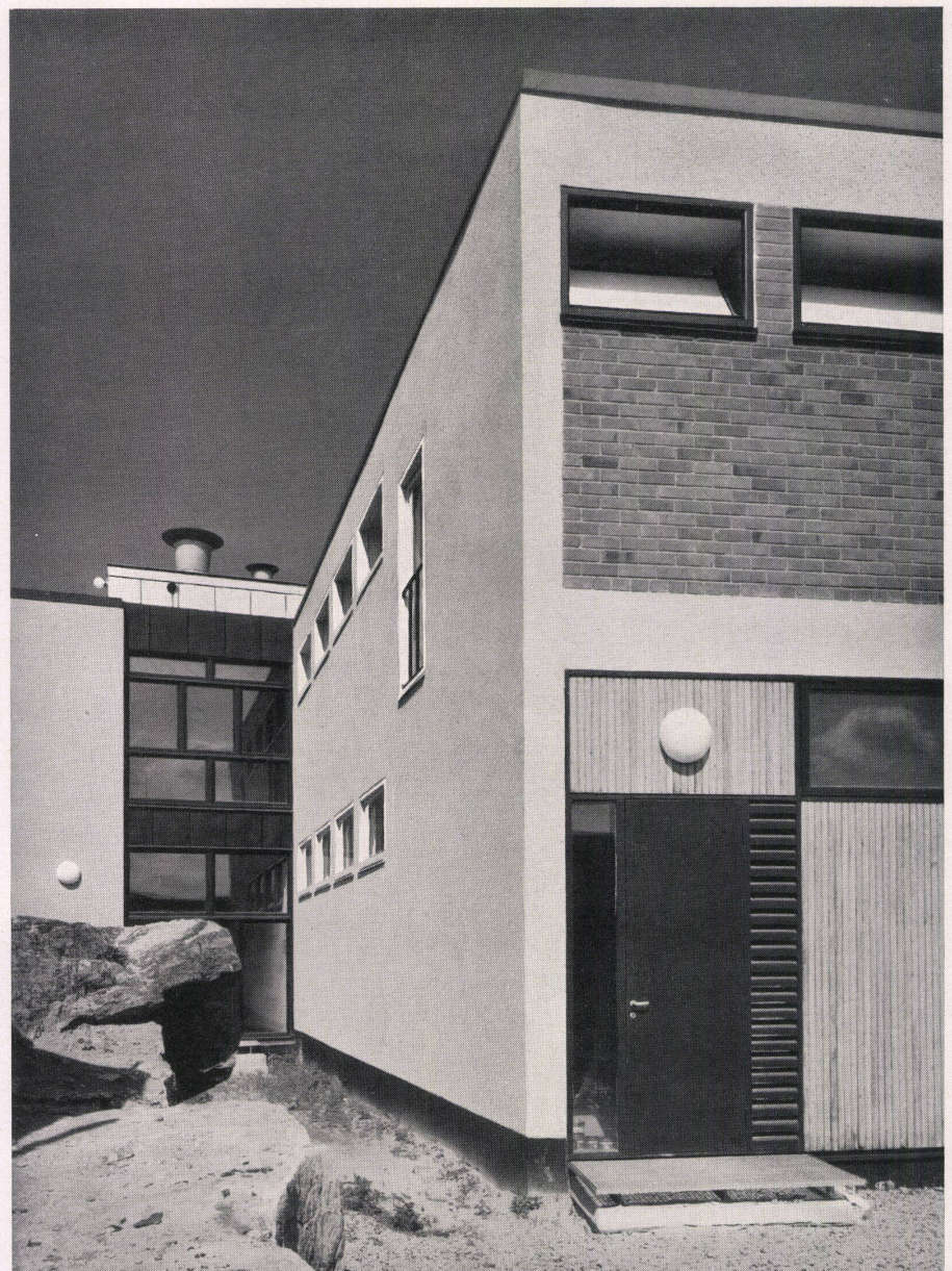
1 Neuer Eingang mit Windfang. Schreinerarbeit schwarz gebeiztes Eichenholz, Wände: roter Sichtbackstein. Boden: graue Plastikplatten. Natur-Deckenputz.
