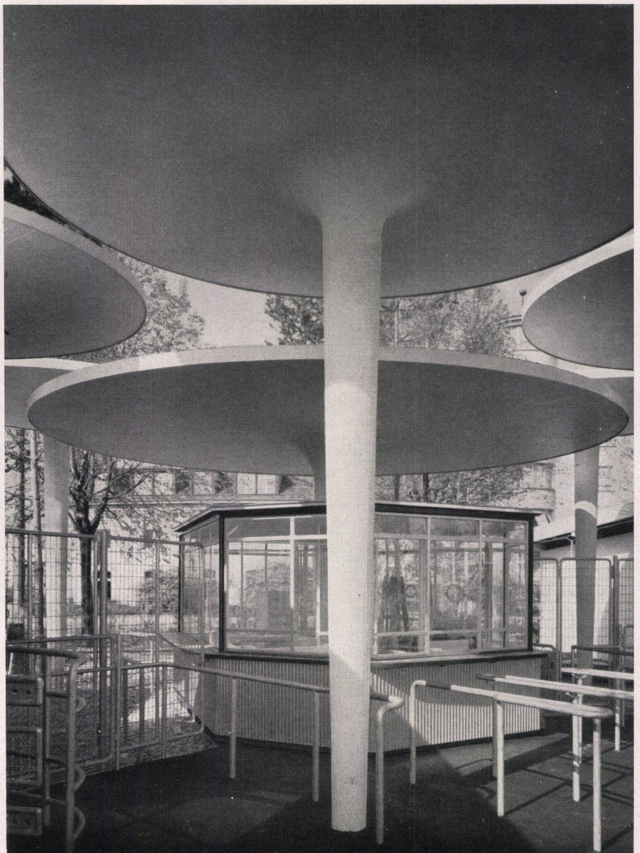
2 Über dem verglasten Kassenhaus wölben sich schattenspendende Betonpilze verschiedener Höhe. Des champignons en béton de différentes hauteurs projettent leur ombre sur le bloc vitré de la caisse. Mushroom-shaped concrete pillars of various heights shade the glazed-in ticket office.
