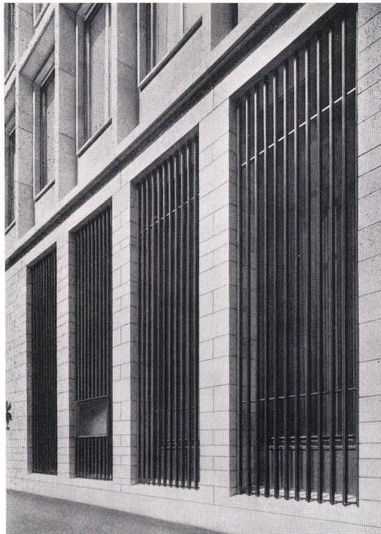
Die 4,2 m hohen Fenstergitter mit eingebauten Schaukasten. Gitter und Vitrinen-Rahmen sind aus stranggepreßten Bronze-Profilen zusammengebaut.
