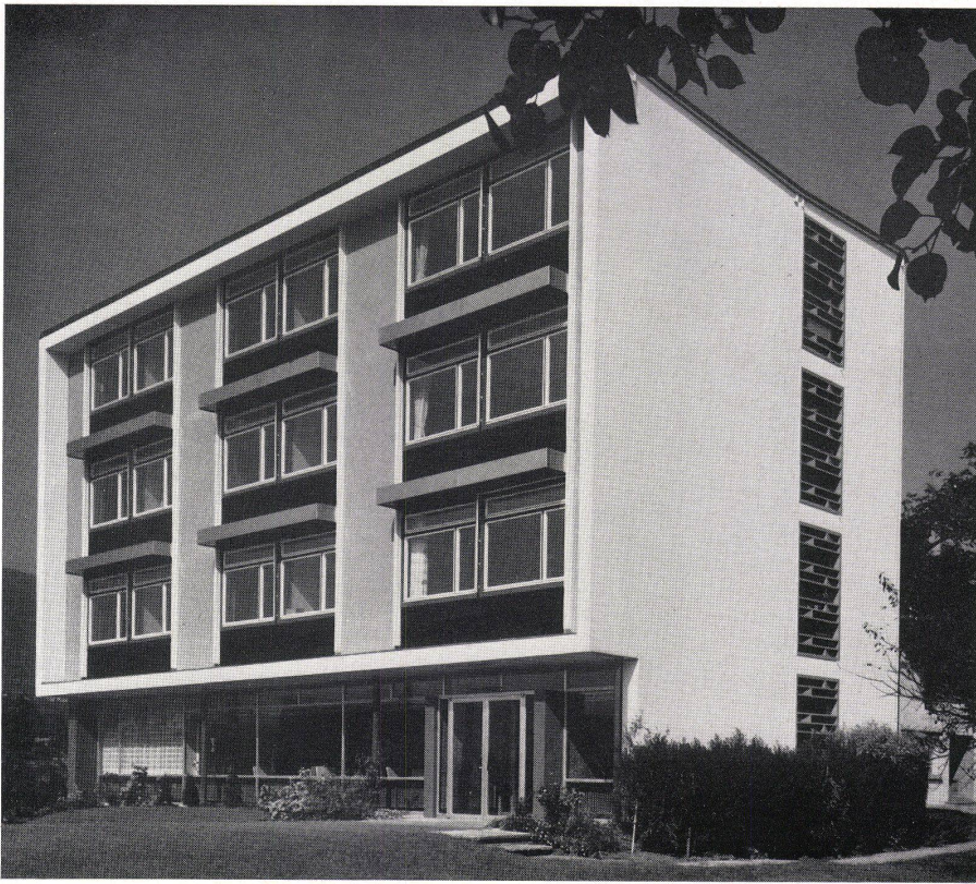
Südwestansicht mit Blick gegen den Haupteingang. Die Südfassade rechts wird den zukünftigen Erweiterungsbau der 2. Etappe mit dem neuen Ausstellungsraum im Erdgeschoß und weiteren Bürogeschossen aufnehmen. Vue prise du sud-ouest vers l'entrée principale. View from southwest towards the main entrance.
